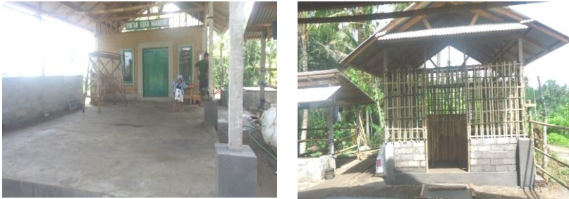
Gambar 7.3. Bangunan rembug kelompok dan bangunan fermentasi pupuk kandang
